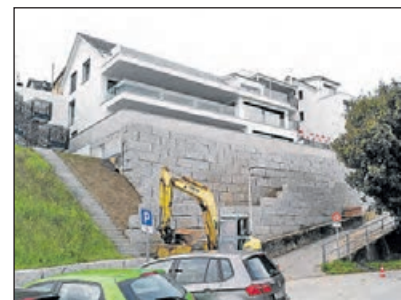
«Felsen» in Birrwil: Keine Kletterwand, sondern eine Hangsicherung für neue Wohnbauten. (Bild: zVg.)
